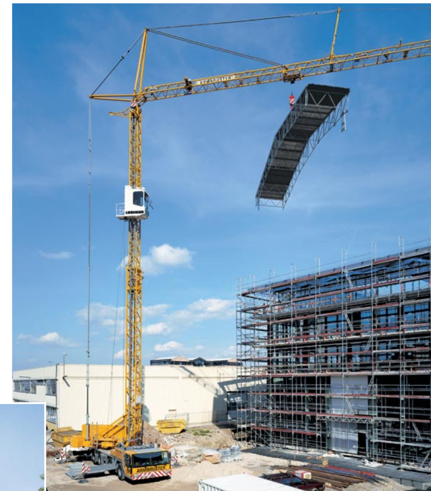
Manutention d'éléments préfabriqués. Charge : 8,0 t.
